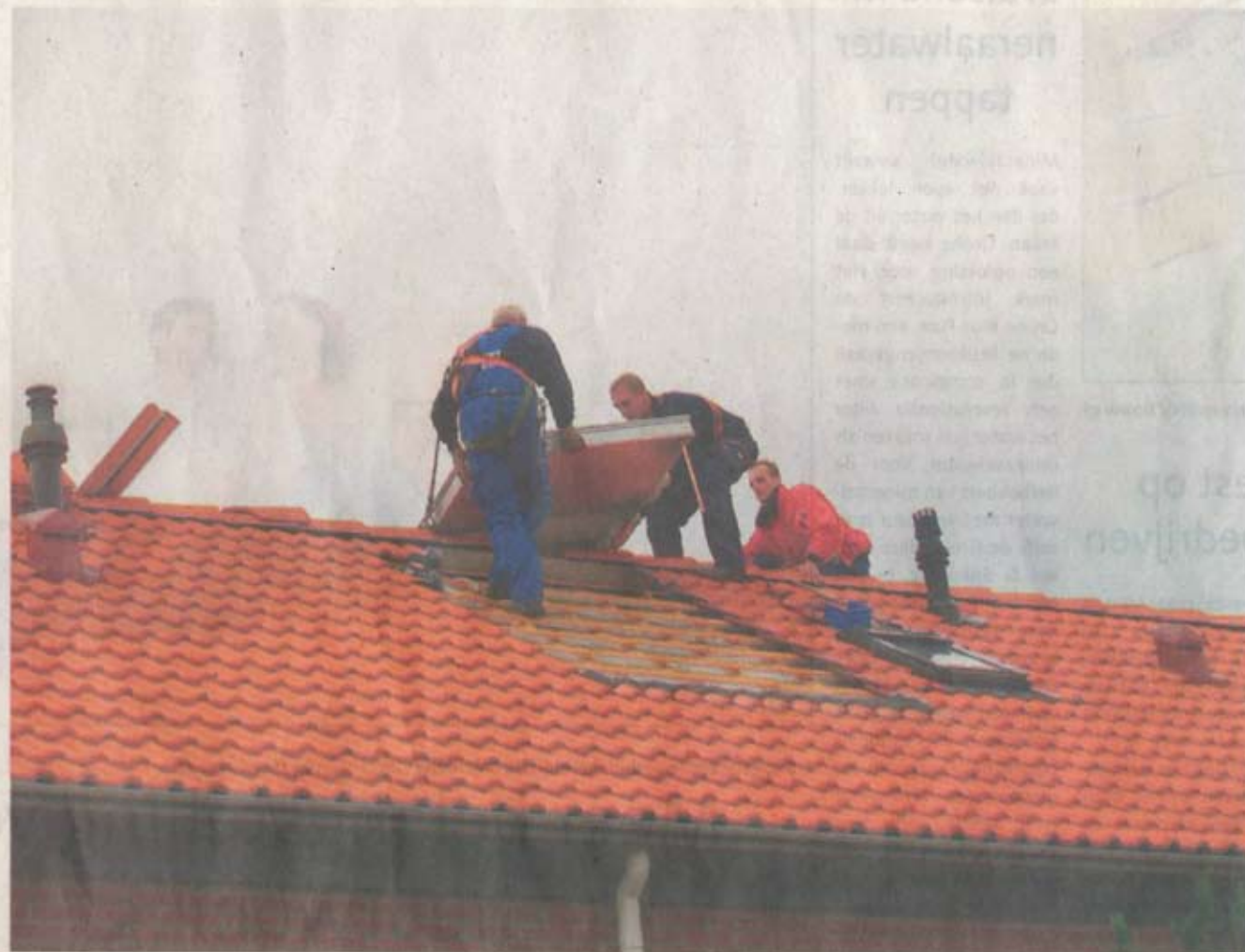
Op een huurhuis aan de Burgemeester Raatlaan in Wervershoof wordt een zonnecollector geplaatst.
